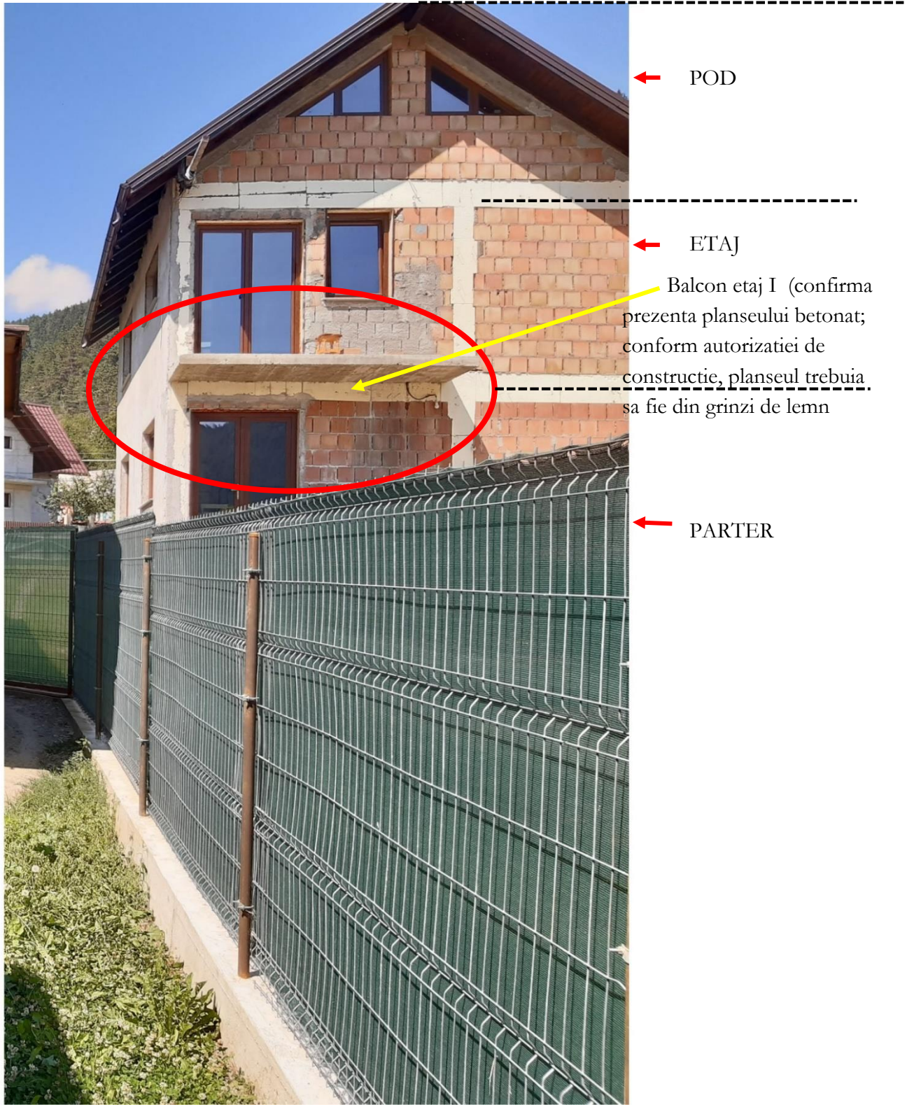
Poza 04 – Constructie finala formata din demisol+parter+etaj+pod
